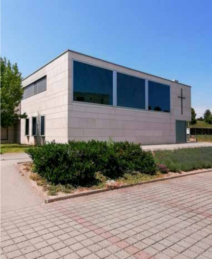
LES NOUVEAUX BUREAUX DU CRPL À GRANGES-PACCOT
